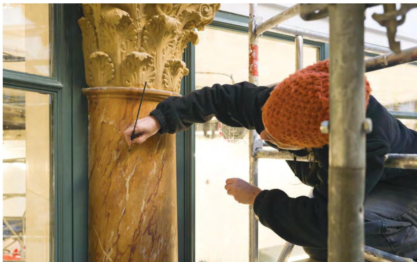
La rotonde de la galerie Colbert en travaux. © François Doury, 2024.
